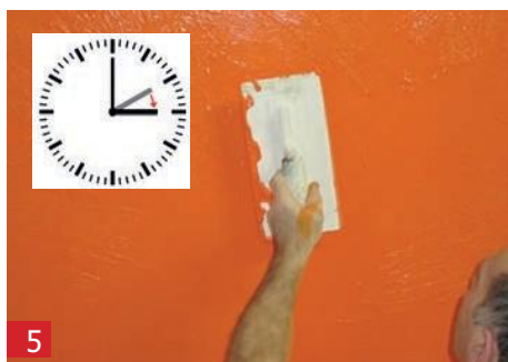
5 使用灰泥在第一A1灰泥层中创建一些结构（或其他工具）。处理时间最长 1小时。
