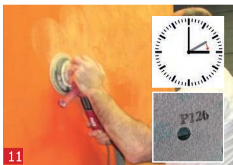
11 固化（约1小时）后，用P120（细）砂纸打磨第二层，直到表面光滑为止。
