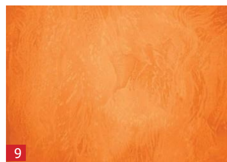
9 第一层打磨后的结果。砂纸打磨后，可立即使用第二层A1灰泥。
