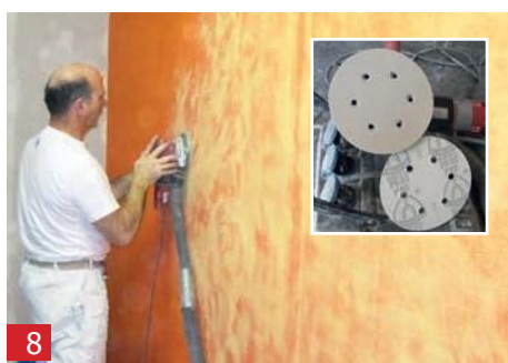
8 固化（约1小时）后，用P80砂纸轻轻打磨表面。
