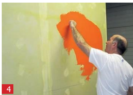
4 使用灰泥涂上第一层A1灰泥并使其平整（约1毫米厚）。
