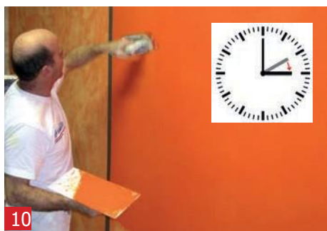
10 混合新量的A1灰泥并在表面上涂第二层并使其平整。您可以使用相同或不同的颜色。
