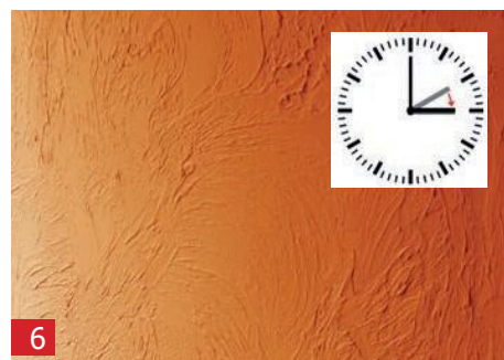
6 结果：A1灰泥的第一层。可以刮掉尖锐的直立边缘...
